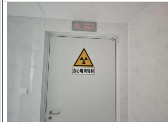
污物打包门（平开铅门、门灯连锁）
