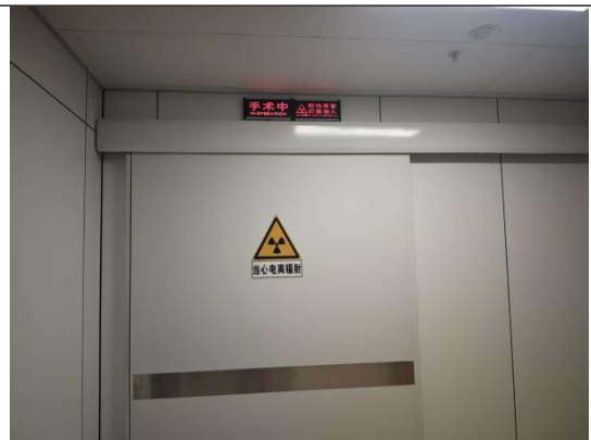
复苏室患者进出门（推拉铅门、门灯连锁）
