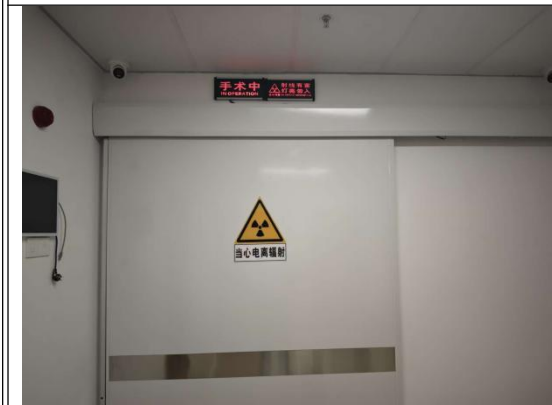
医护进出门（推拉铅门、门灯连锁）
